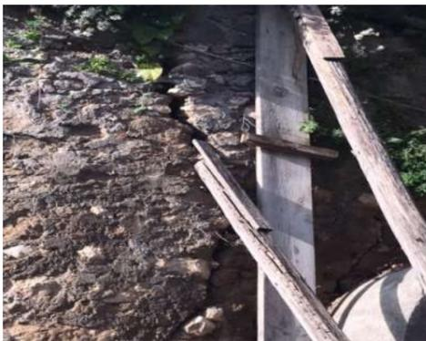
critiche e vede un parcheggio sottostante presso Piazza Mattei. È un muro molto vecchio, costruito agli inizi del secolo scorso. Le condizioni del muro sono pessime e sono state applicate delle travi per bloccare il fenomeno di crepatura che lo sta caratterizzando ormai da tempo: il muro sta crollando. Le travi sono di legno e sono oggetto di obsolescenza a causa dei fenomeni atmosferici e si consumano di conseguenza. Tra l'altro, applicare le travi direttamente sulle spaccature,
